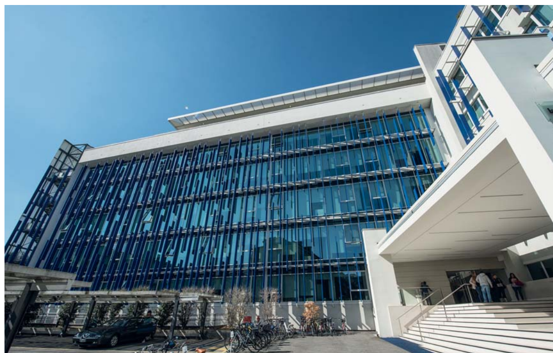
Palazzo Alpitour di via Lugaro
